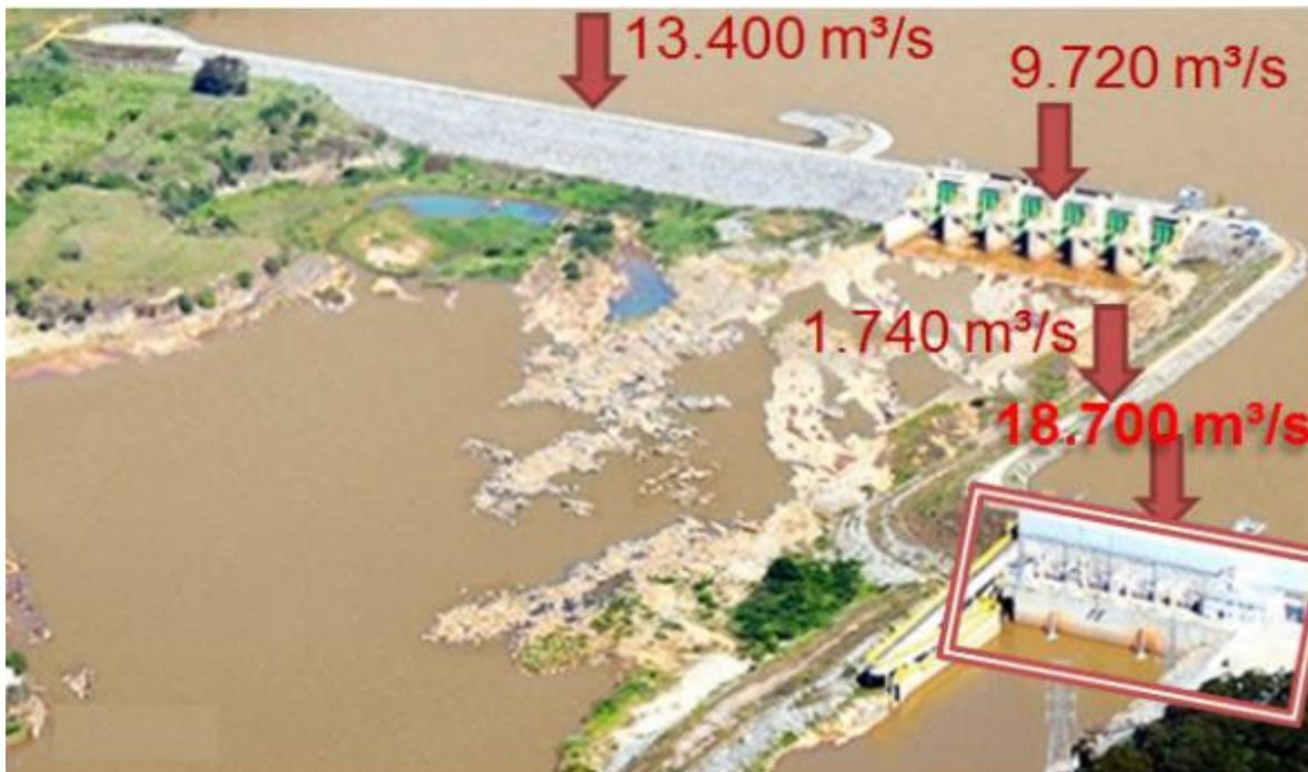
**Figura 4 – Cenários de ruptura estudados para a UHE Baguari para a vazão decamilenar**
